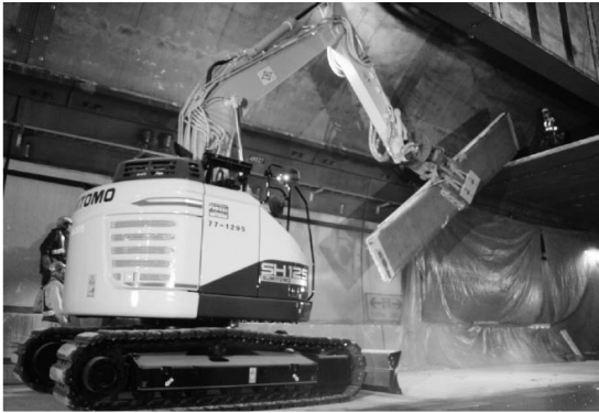
写真は天井板撤去状況
