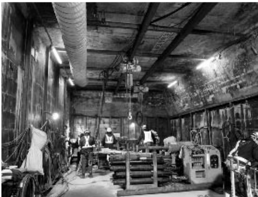
写真は水平地盤改良状況
