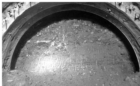
写真は砂礫区間の切羽状況
