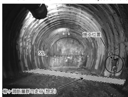
写真はコアボーリングの施工位置
