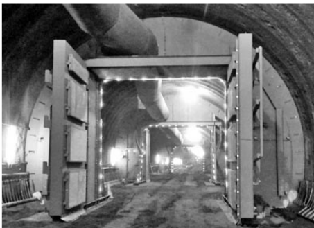
写真は防音扉(水充填+コンクリートパネル式)
