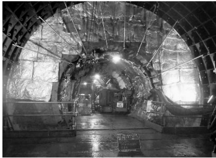
写真は凍土面防熱材設置状況
