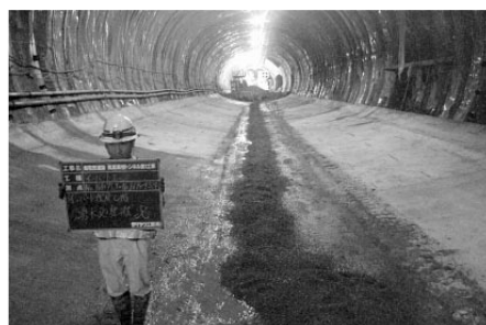
写真は仮暗渠排水管設置
