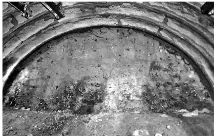
写真は高精度電子雷管装薬状況
