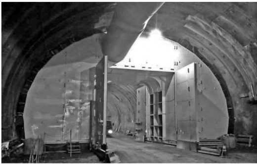
写真は移動式一体型防音扉設置状況
